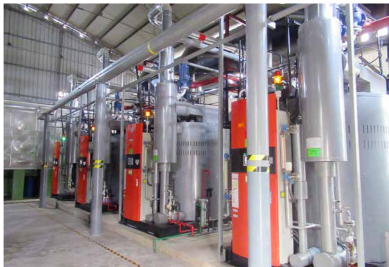
天然气锅炉改造
