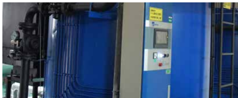
▲ 三水公司天然气锅炉
