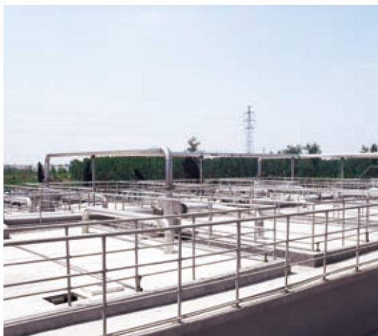
厌氧池沼气收集管路
