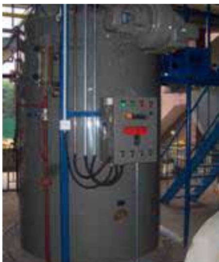
深圳厂沼气锅炉
